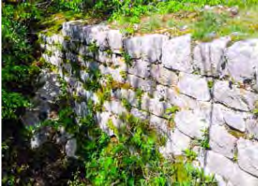
Foto 3. Muret rrethuese të Ballezës
