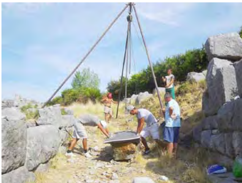
Fig.6. Punime restauruese në muret rrethuese, pjesa kodrinore. 2016
